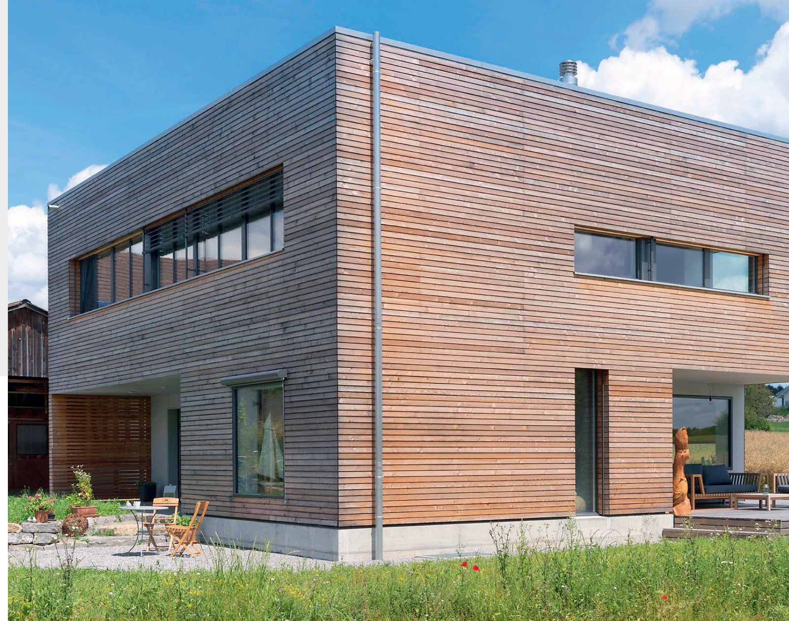
Eine Holzfassade ist der perfekte Abschluss gegen aussen für einen Holzbau mit Zellulosedämmung.
