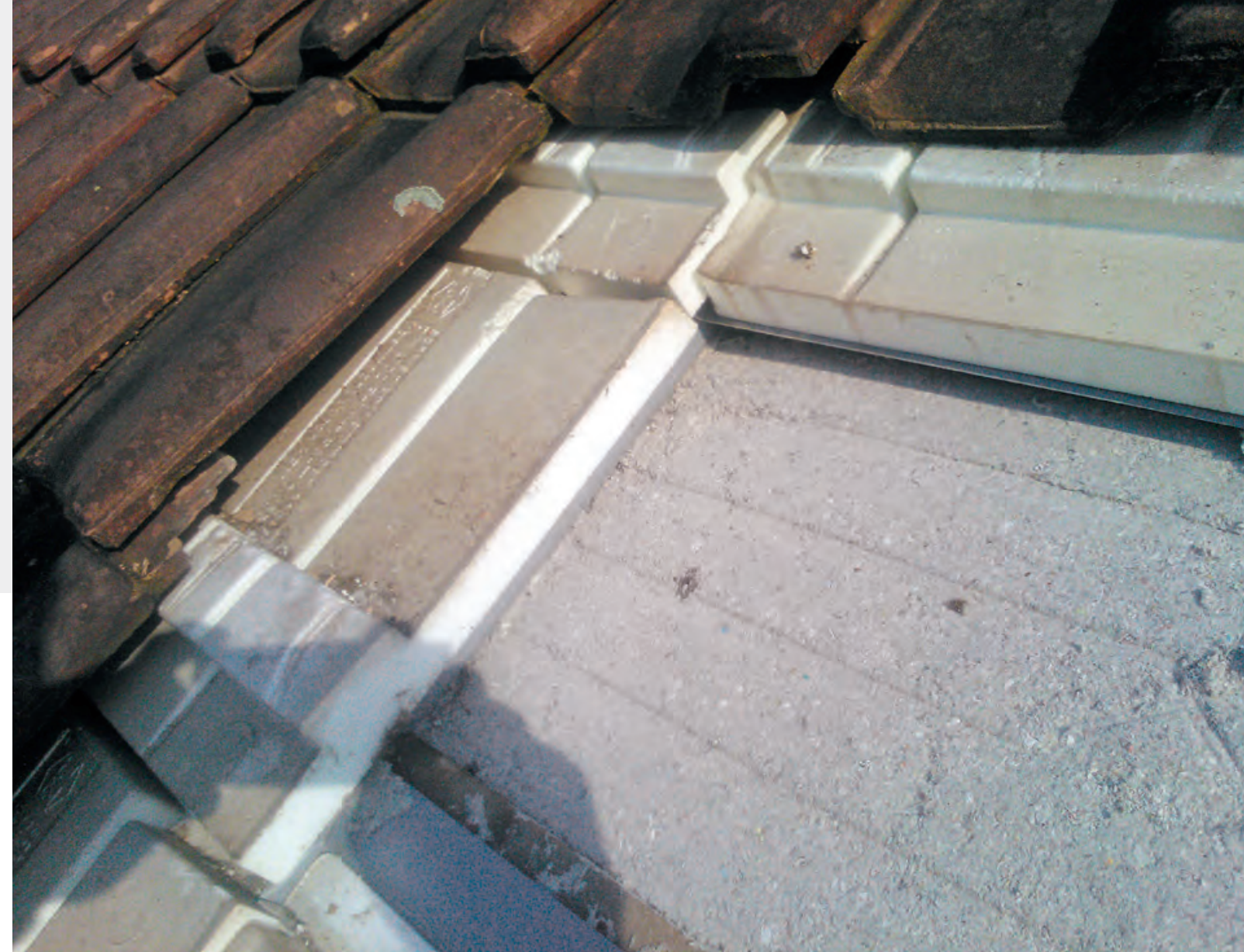
Einsicht in geöffnetes Steildach mit oberliegender bestehender Dämmung. Sehr gut sichtbar die lückenlose Dämmschicht des isofloc Zellulosedämmstoffs.
