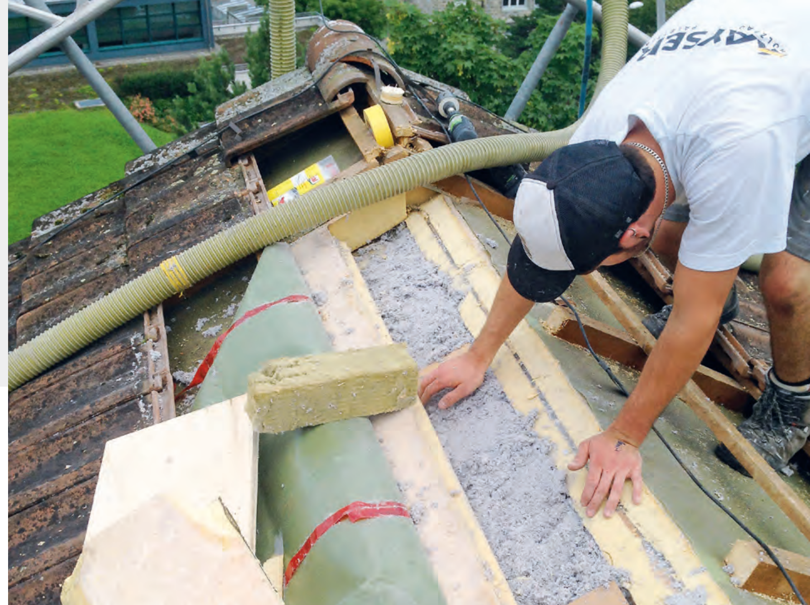
Das Schrägdach wird vom First her mit isofloc Zellulosefasern ausgeblasen.
